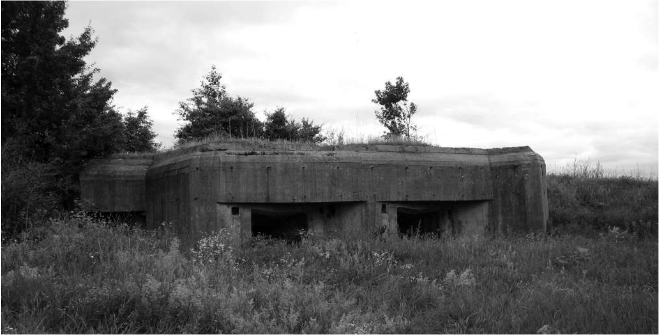
Фото 2. Артилерійський напівкапонір для двох 76 мм гармат (установка Л-17)
