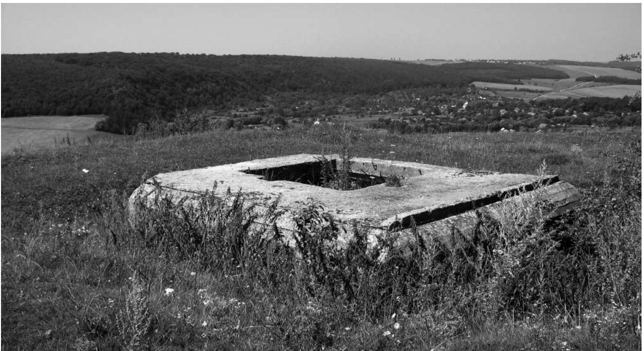
Фото 7. Недобудований спостережний пункт (не встановлено броньовий ковпак)
